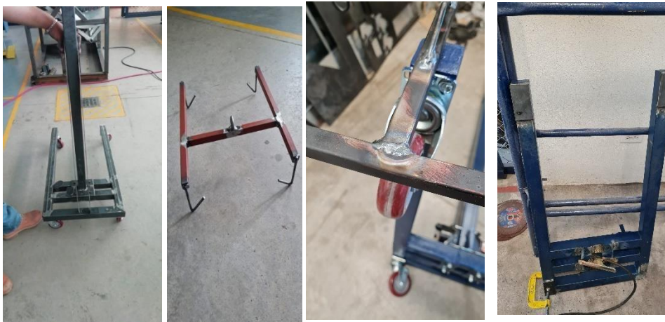
ILUSTRACIÓN 7: ELABORACIÓN DEL CHASIS DEL VEHÍCULO-GRÚA MEDIANTE LE PROCESO DE FABRICACIÓN MIG O MICRO ALAMBRE CON ATMOSFERA CONTROLADA DE GAS CO 2 .
